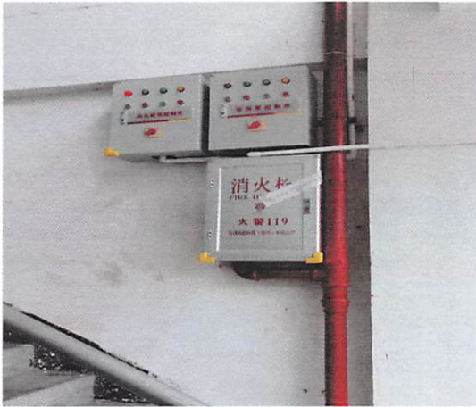
10. 新庵分园易碰头电箱加装防撞棉后图片
